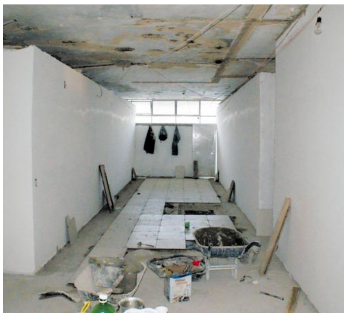
As obras para a construção dos campos de futebol e novos vestiários já começaram.
